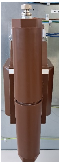
Obrázek 4: Postup vyjmutí pojistkové vložky (patrony) z pojistkového pouzdra
