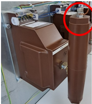
Obrázek 3: Vyznačení místa odpojení VN části
