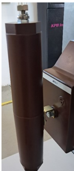
Obrázek 4: Postup vyjmutí pojistkové vložky (patrony) z pojistkového pouzdra
